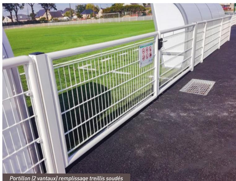
Portillon (2 vantaux) remplissage treillis soudés
